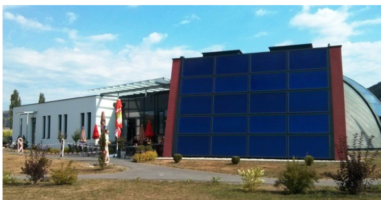
Abbildung 3-14.: Ansicht des 50 m 2 großen Kollektorfeldes an der Fassade eines Anschlusskunden (links) sowie Ausschnitt des 85 m 2 großen Kollektorfeldes am Dach des Kunden (rechts), Bildquelle: AEE INTEC
