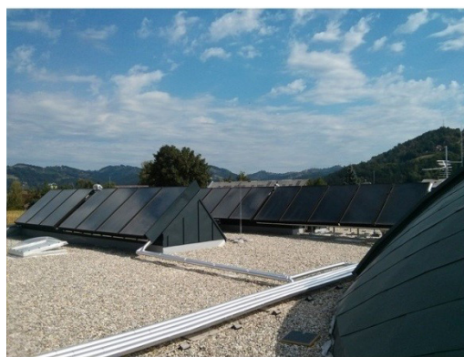
Abbildung 3-14.: Ansicht des 50 m 2 großen Kollektorfeldes an der Fassade eines Anschlusskunden (links) sowie Ausschnitt des 85 m 2 großen Kollektorfeldes am Dach des Kunden (rechts), Bildquelle: AEE INTEC
