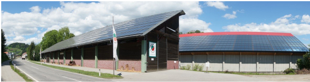
Abbildung 3-11: Ansicht der beiden Kollektorfelder als Panoramafoto (links: 1.250 m 2 Altbestand; rechts: 1.200 m 2 Neubau) der Anlage „Nahwärme Eibiswald“, Bildquelle: AEE INTEC
